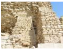
Кладка пирамиды Джосера из небольших известняковых блоков связанных глиняным раствором
